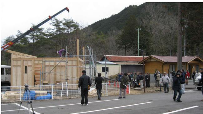
間取りは4.5畳が田の字に4つ集まったシンプルなもので、屋根・外壁をガルバリウム、断熱材をウッドファイバー、床壁を地元産の杉の無垢板パネルで作るなど自然素材にこだわった造りとなっています。延べ床面積9坪で基礎を除いて建築費396万円ですから、比較的経済的で、一般住宅にも採用できるのではないのでしょうか。
