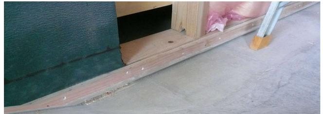
■間仕切壁の木柱が鉄骨梁にクランプで仮止めされたまま：仮設は不可、本設固定を指示しました。構造設計者から風圧力を考慮し鉄骨補強の提案がありましたが、現場上向き溶接に頼ることを指摘しました。結果：監理建築士・構造設計者が責任を持つことで決着しました。
