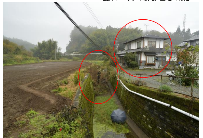
護岸ブロックの崩壊・住宅の傾き
