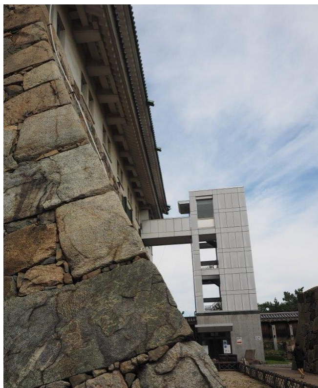
名古屋城天守閣外部エレベーター
