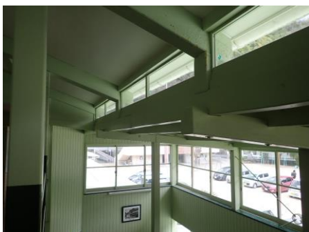
2階廊下の梁組み
