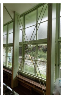
ダブルの鉄筋スジカイ
