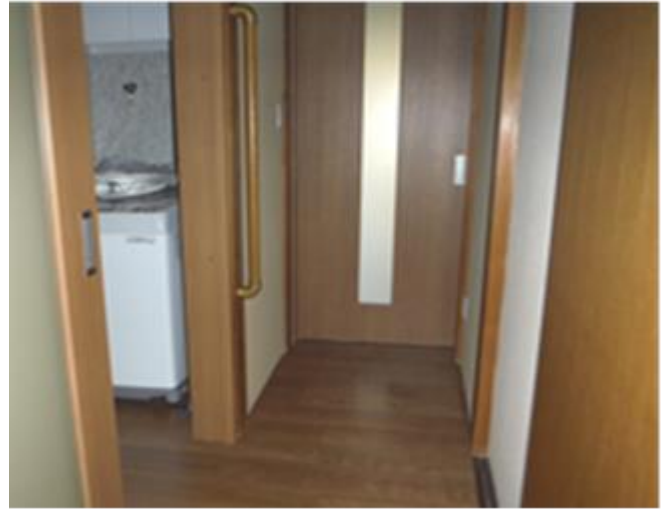
廊下の引込戸
