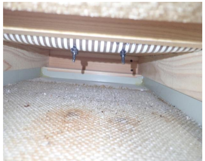
冷熱パネルと散水口
