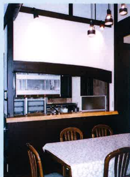
天井を解体して吹抜け空間へ
