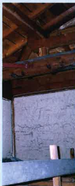
改修前天井裏
